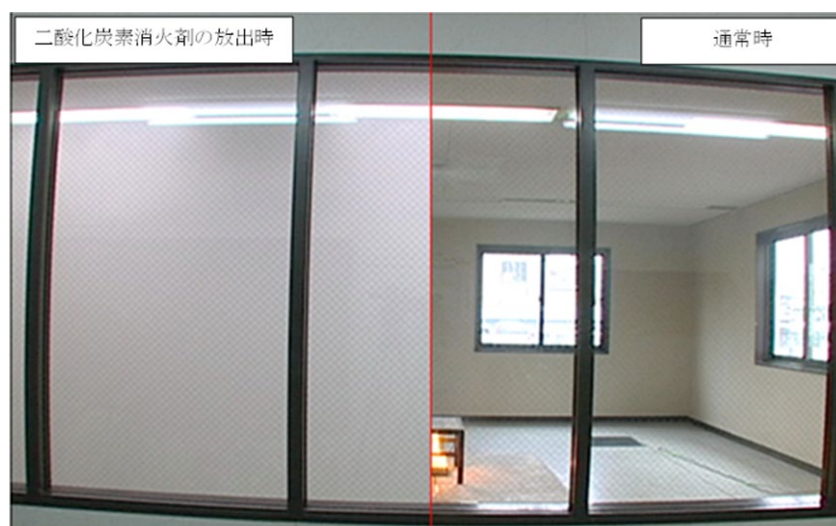
図 二酸化炭素消火剤の放出時と通常時における視界の比較
